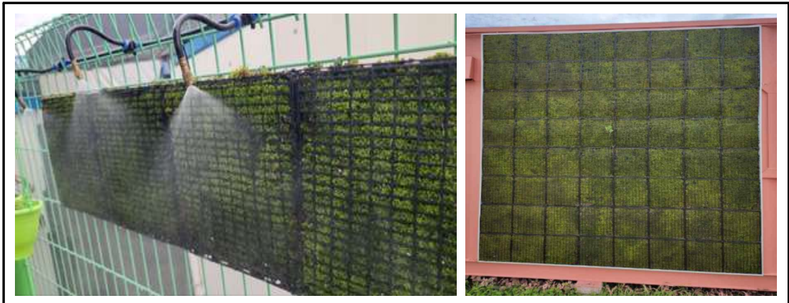
그림 26. 울타리(좌) 및 벽면(우)에 설치된 수직 이끼네트
