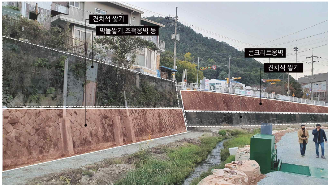
[서측좌안 옹벽 현황]
