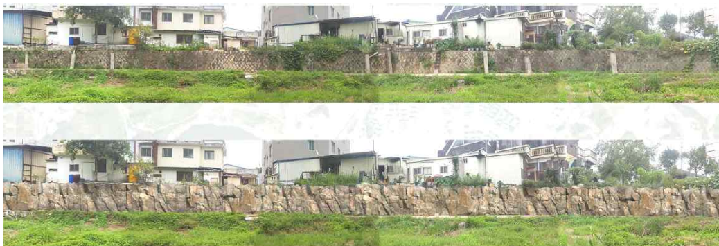
[동측우안 옹벽 인공암반 조성예시]
